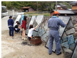
窓枠サッシ塗装
