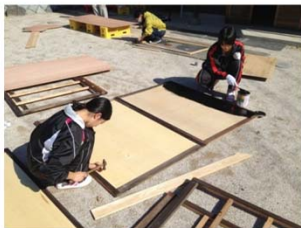
2階雨戸と戸袋の改修
