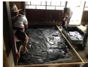
屋内左官工事
