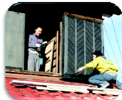
地元の方との雨戸取付の様子
